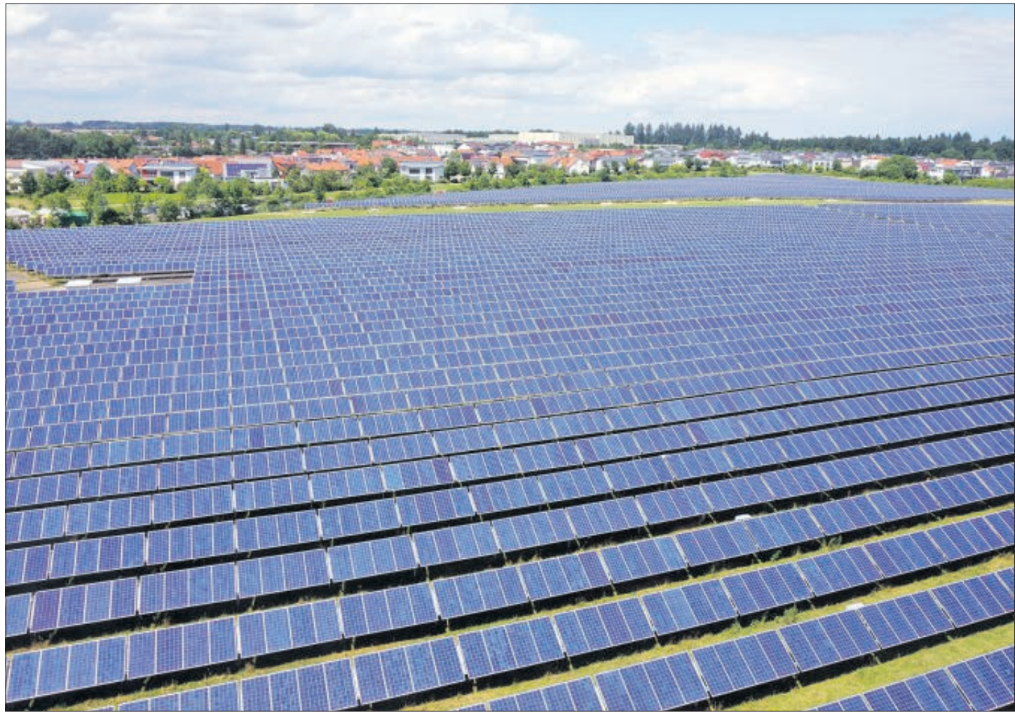
Blick über den Solarpark Mutlanger Heide von oben. Der unbebaute Einschnitt markiert den Verlauf des Limes.
